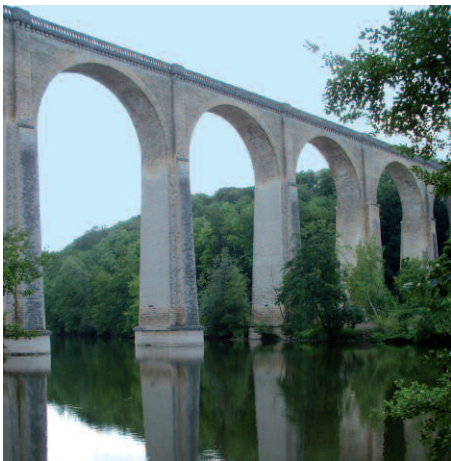
Viaduc (Le Blanc - Indre).
